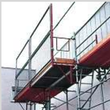
Dachfanggerüst mit Ausschusskonsole
